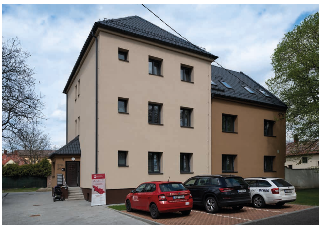
▲ Dokončené sociální byty v Ostravě-Kunčičkách nabízí stabilní zázemí 6 nízkopříjmovým rodinám. Foto: V. Curylo, Člověk a Víra
