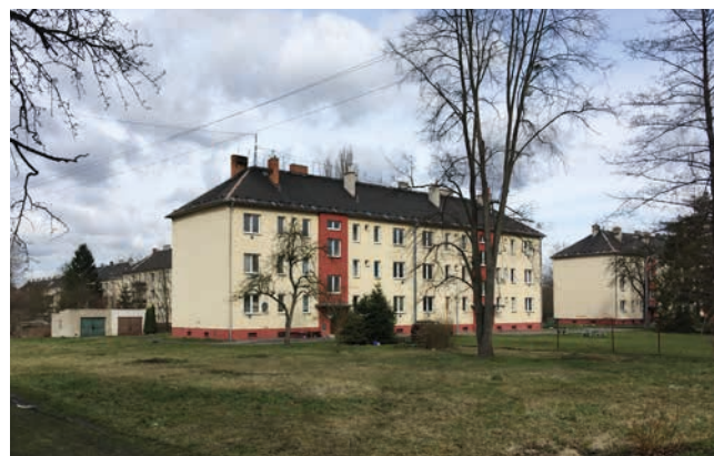
▲ Šance domova působí v sociálně vyloučené lokalitě v Ostravě-Kunčičkách, kde pomáhá místním s problematikou bydlení. Foto: archiv DCHOO
